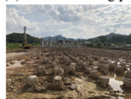
(d) CFG pile
